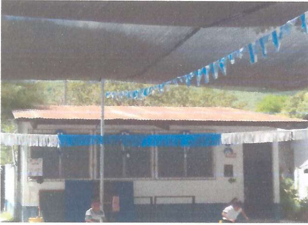
Foto 1: instalación de lámina troquelada
