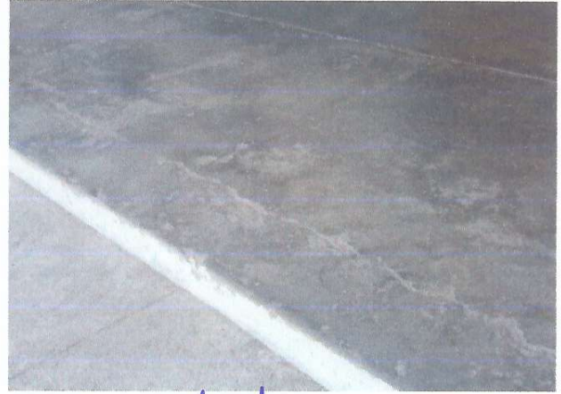
Foto 2: Reforzamiento de aceras y banquetas
